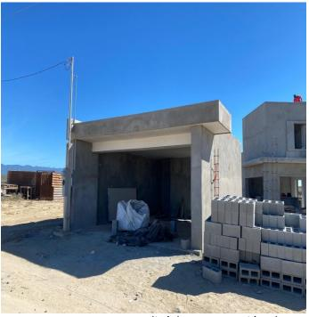
En este proyecto se realizó la construcción de una vivienda de dos niveles, y una cochera exterior, a base de cimentación tipo zapata corrida y aisladas, con una densidad alta muros de mampostería, acabado exterior con cemento pulido y yeso en el interior y plafones.
