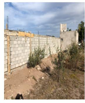
En este proyecto se realizó la construcción de una barda lateral con un total de 80 m lineales, a base de mampostería, confinada con castillos armados en sitio, con una zapata corrida de lindero de 60 cm de ancho, y una altura de 2.10 m.
