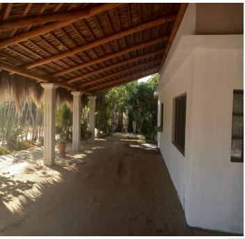
Se realizó una construcción de la estructura de una palapa a base de largueros circulares de madera de pino, y fajilla para la colocación de la cubierta, todo soportado por trabes de madera fijados a estructura de concreto hudráulico existente.
