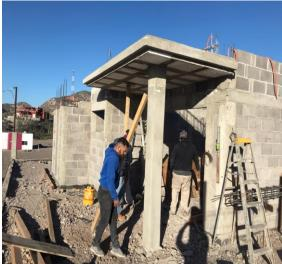
En el proyecto "Casa Mulegé" se realizaron los trabajos a nivel de "obra gris" a base de una cimentación tipo zapatas corridas y aisladas, muros de mampostería, dejando preparaciones de instalaciones hidrosanitarias y eléctricas, listo para recibir losa tipo nervada.
