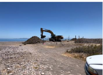
En el proyecto "El Faro" se realizó el trabajo preliminar correspondiente a preparación y mejoramiento del suelo debido a recomendación de mecánica de suelos, para recibir cimentación. La cimentación se realizó a base de zapatas corridas y zapatas aisladas.
