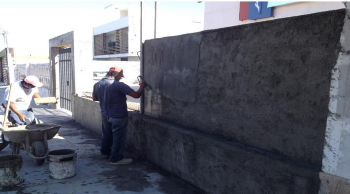
Se realizó la construcción de una fachada, a base de una cimentación de zapata corrida, con levantamiento de muro de mampostería y preparación para barandal de herrería, y un marco en entrada principal colado con concreto hecho en sitio.
